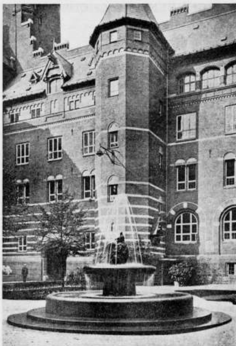
BINNENPLAATS RAADHUIS TE KOPENHAGEN. M. NYROP ♀, ARCHITECT.
