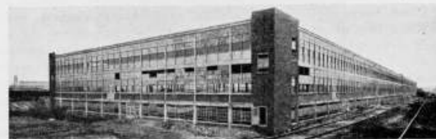
(AFB. 14). FABRIEK. VOORBEELD VAN TEGENSTELLING TUSSEN DE OPENHEID VAN GLAS EN IJZER EN DE GESLOTENHEID VAN MUURWERK, WAARBIJ VAN DE ESTHETISCHE MOGE- LIKHEDEN DAARVAN NOG GEEN PARTIJ IS GETROKKEN.
