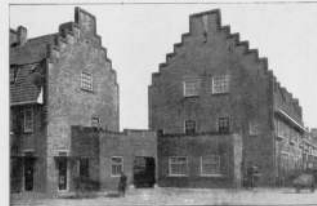
GEMEENTEL. WONINGBOUW IN DE TRANSVAALBUURT TE A'DAM ARCH. DR. H. P. BERLAGE, JAN GRATAMA EN G. VERSTEEG
