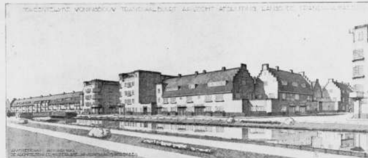
GEMEENTELIJKE WONINGBOUW IN DE TRANSVAALBUURT TE A'DAM □ ARCH. DR. H. P. BERLAGE, JAN GRATAMA EN G. VERSTEEG
