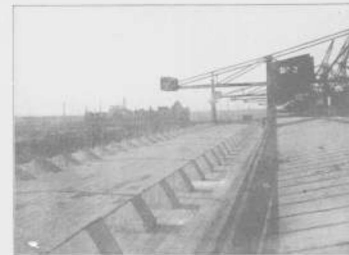
BETONDAKEN DER LOODS „ROTTERDAM“ VAN DE HOLLAND-AMERIKALIJN
