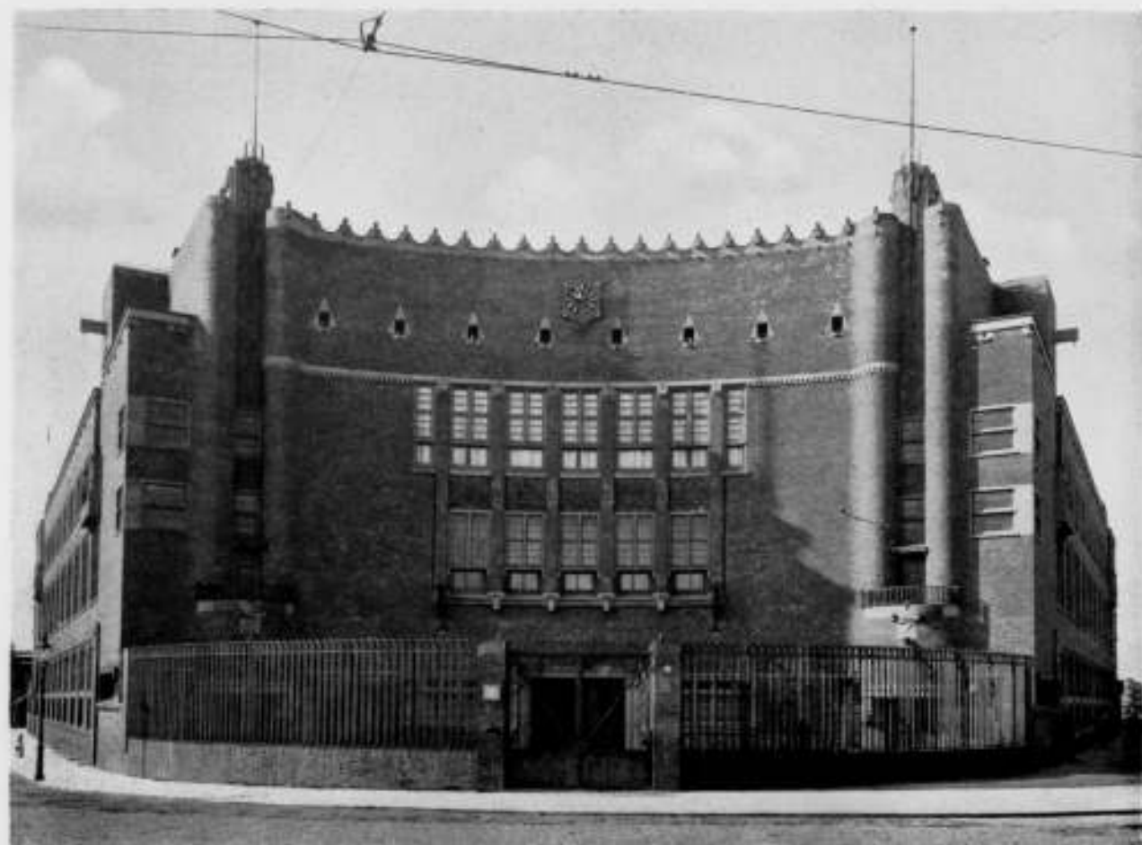
VIERDE AMBACHTSSCHOOL, HOEK KOSTVERLORENVART
