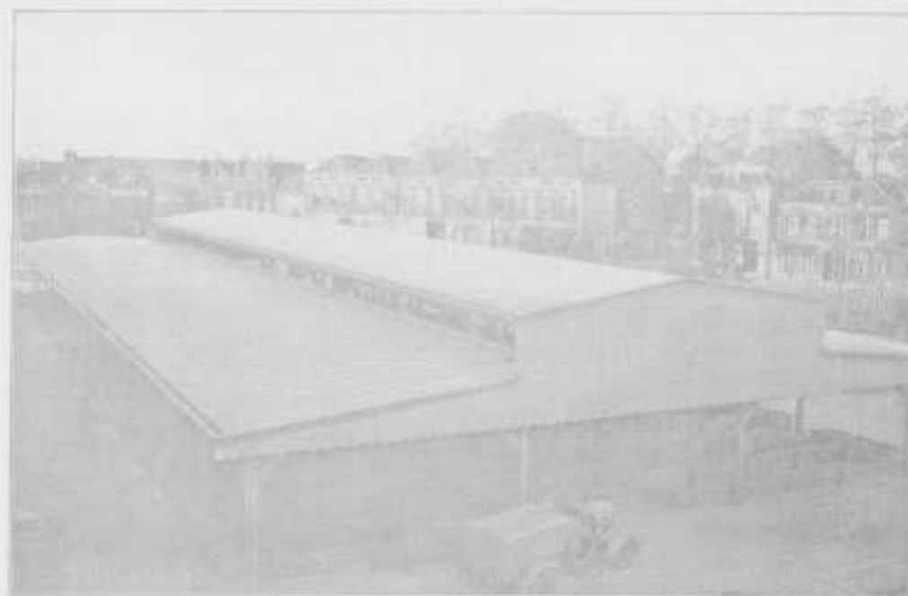
OVERKAPPING VEEMARKT GOUDA, AFGEDEKT MET GRIJZE „RU-BER-OID“ DAKBEDEKKING OPPERVLAKTE PLM. 1500 M 2 .
