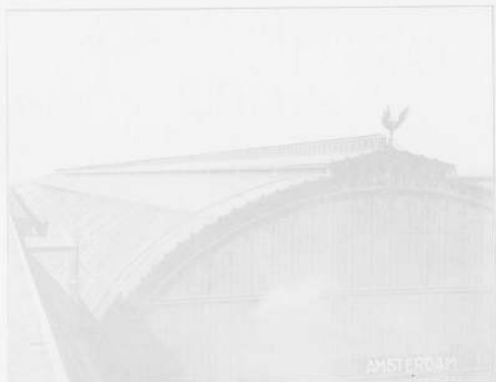
ERSTE PERENNIEVENKAPPING DOOR DAKBEDEKKING VAN HET CENTRAAL STATION, AMSTERDAM, VOORZIEN VAN EEN „RUBEROID“ DAKBEDEKKING TOT EEN GEZAMENLIJKE OPPERVLAKTE VAN 1000 M 2
