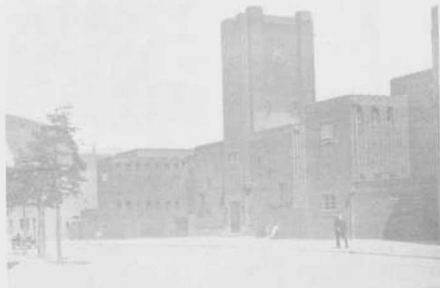
SCHOOLGEBOUW AAN DE LEXSTRAAT TE SCHIEDAM, WAARVAN DE PLATTE DAKEN IN 1923 AFGEDEKT ZIJN MET „RU-BER-OID” CEMENT DAKBEDEKKING OPPERVLAKTE PLM. 900 M 2
