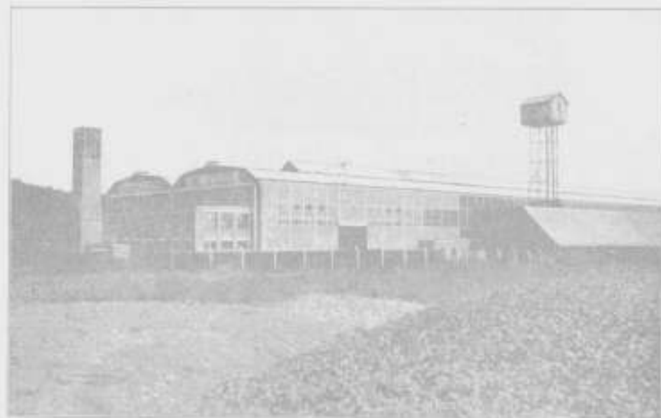
FABRIEKSGEBOUWEN DER NV. MOTOREN. EN MACHINEFABRIEK VAN FIRMA THOMASSEN & Co., DE STEEG. AFGEDEKT MET
