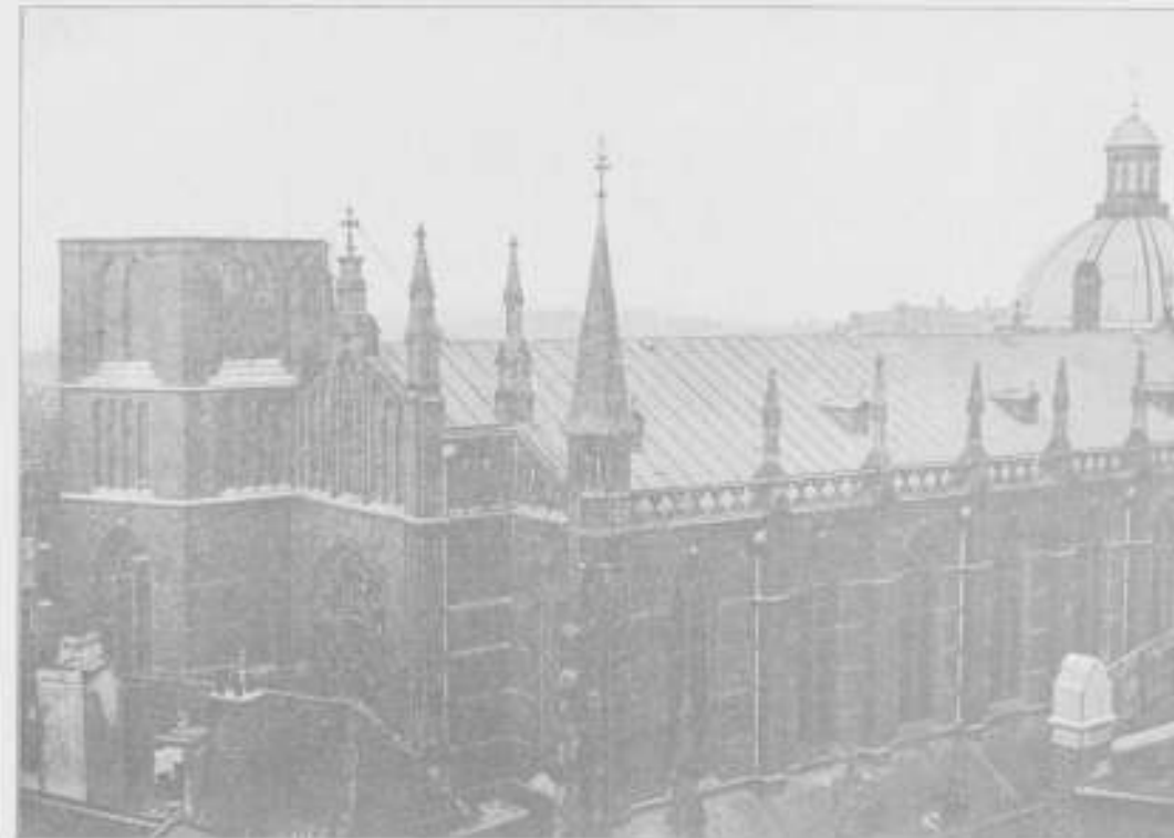
BOXENKAMER VAN DE ST. DOMINICUSKERK, SPIJKSTRAAT AMSTERDAM, WAARVAN DE DAKVLAKKEN ZIJN AFDEKKT MET
