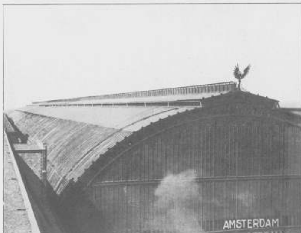
EERSTE PERRONOVERKAPPING (OUDE OVERKAPPING) VAN HET CENTRAAL STATION, AMSTERDAM, VOORZIEN VAN EEN „RUBEROID“ DAKBEDEKKING TOT EEN GEZAMENLIJKE OPPERVLAKTE VAN 8000 M 2 .
