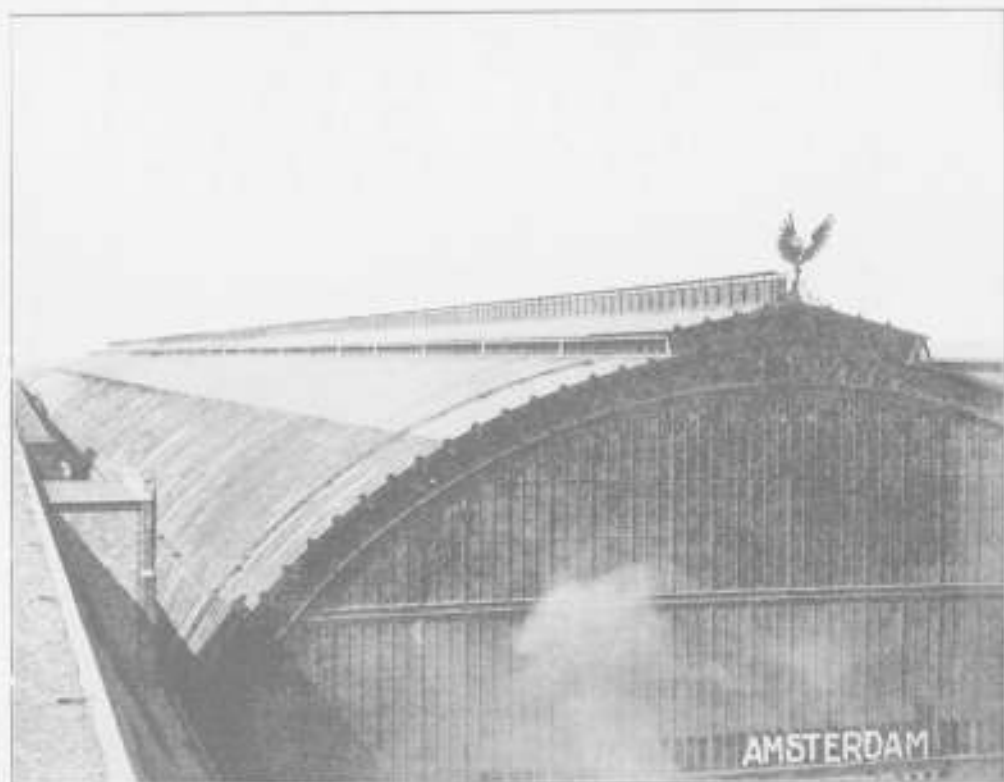
EERSTE FERRONOVERKAPPING (OUDE OVERKAPPING) VAN HET CENTRAAL STATION, AMSTERDAM, VOORZIEN VAN EEN „RUBEROID“ DAKBEDEKKING TOT EEN GEZAMENLIJKE OPPERVLAKTE VAN 6000 M 2 .
