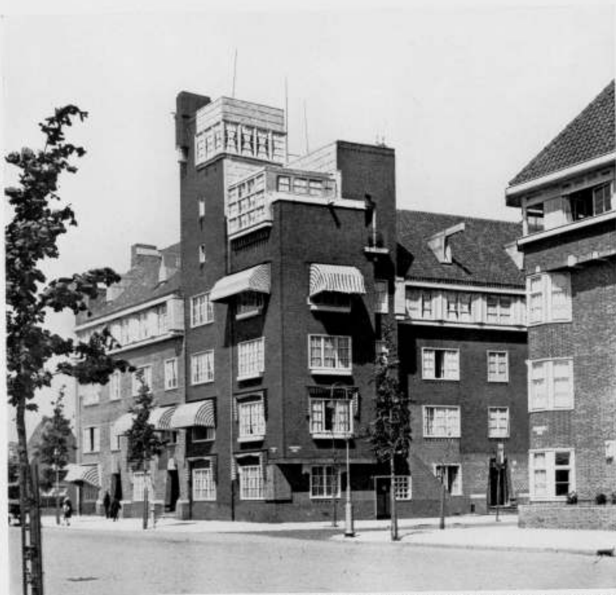
ARCHITECT J. M. VAN DER MEIJ, OVERZIJDE TITIAANSTRAAT. ARCH. PH. A. WARNERS, OLYMPIAPLEIN HOEK TITIAANSTRAAT
