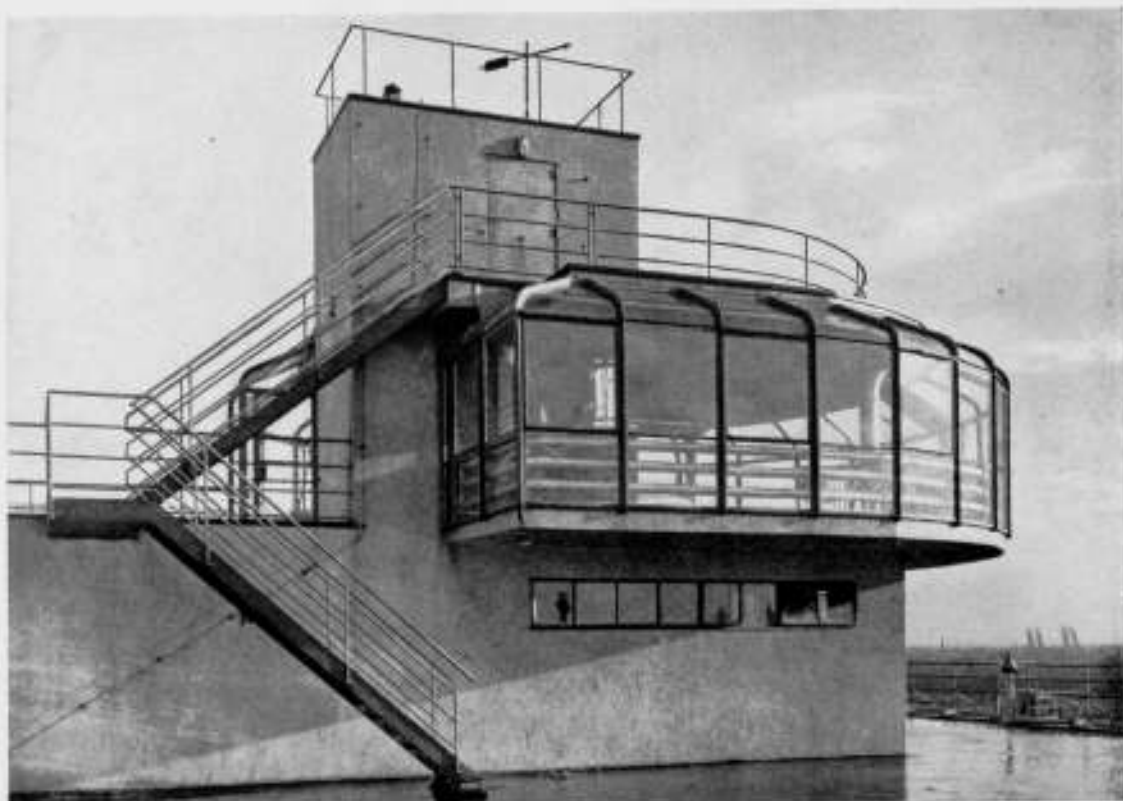
EXTERIEUR VAN DE TEAROOM BOVEN DE FABRIEK
