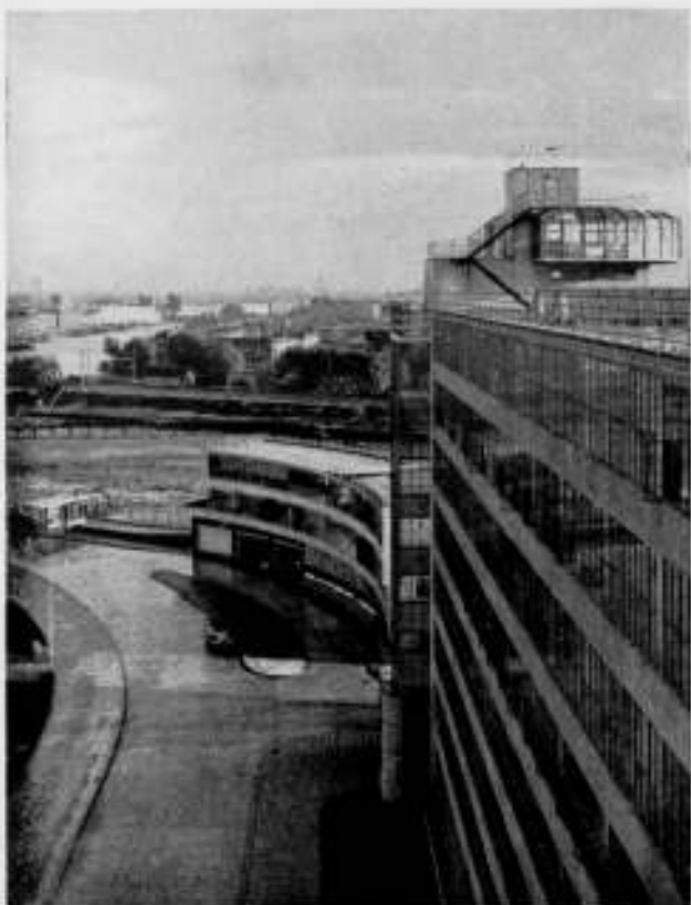
GEDEELTE FABRIEK EN KANTOOR VANAF DE 7e VERDIEPING
