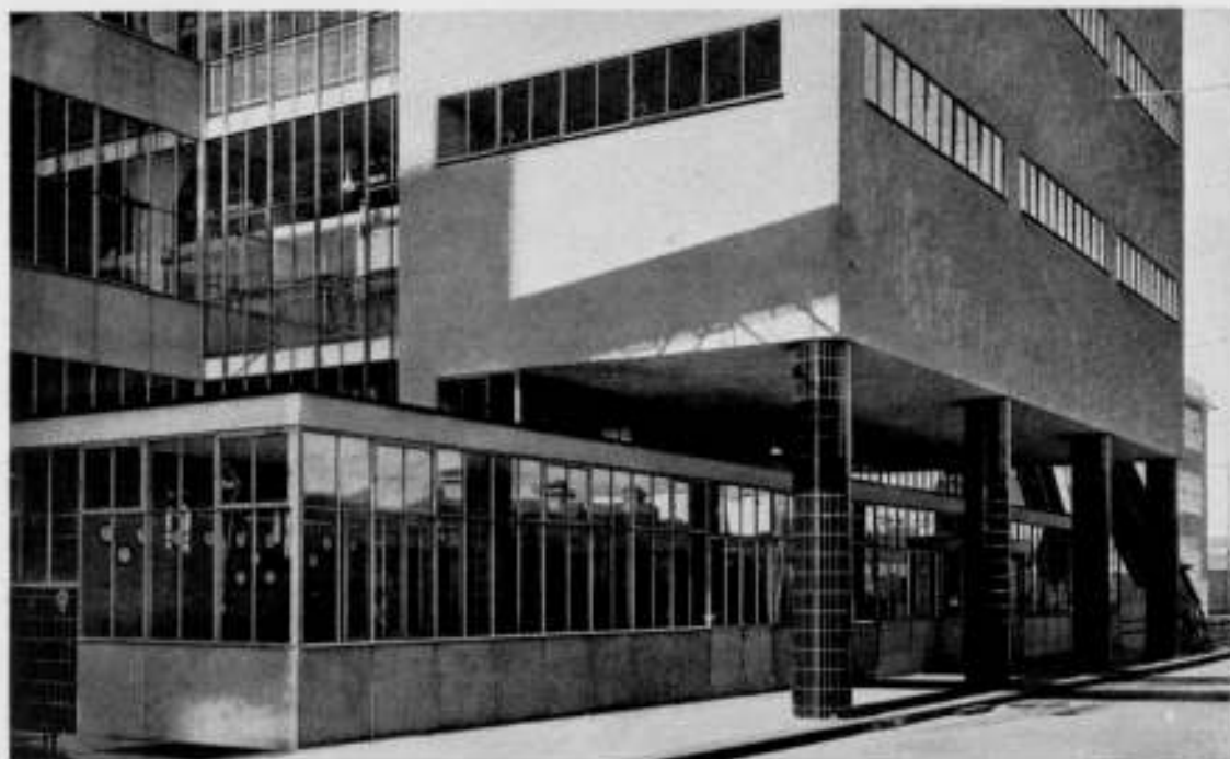
SCHAKELKAMER VAN HET FABRIEKSGEBOUW
