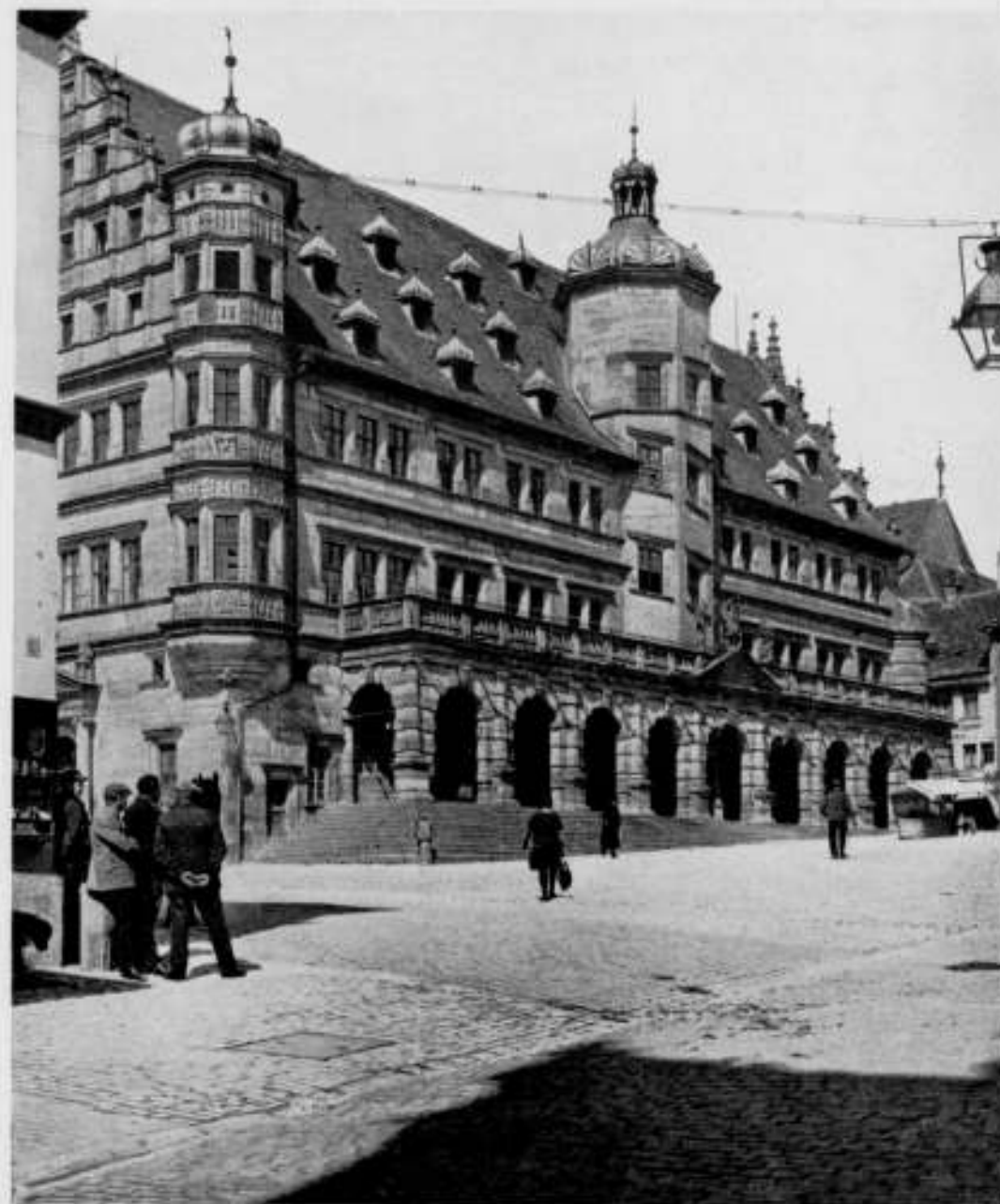
HET STADHUIS OP DE GROOTE MARKT. DE TEGENWOORDIGE BOUW DATEERT UIT HET EIND DER 16E EEUW EN IS DOOR WEIDMANN GEDEELTELIJK IN SAMENWERKING MET EEN NÜRNBERGSCHE ARCHITECT TOT STAND GEBRACHT. NADAT HET ONTWERP WAS GEMAAKT DOOR NIKOLAUS HOFMANN VAN HALLE, DE ARKADENBOUW IS IN 1681 TOEGEVOEGD DOOR DEN STADSBOWMEESTER KASPAR FÖXLEIN. HET GEBOUW BESLAAT DEN GEHELEN WESTELIJKE PLEINWAND; LINKS ACHTER DE HUIZEN LIGT DE HERTERICHBRUNNEN.
