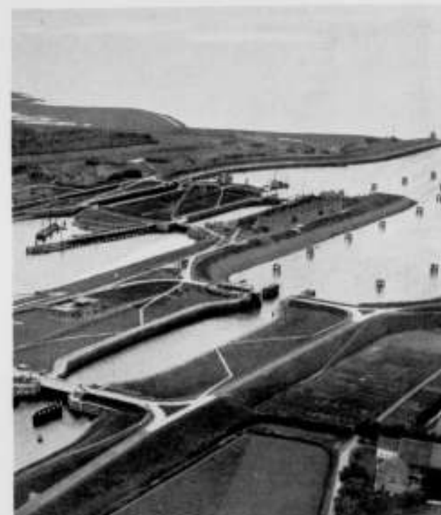
SLUIS IN HET KANAAL VAN ZUID-BEVELAND, TE WEMELDINGE
